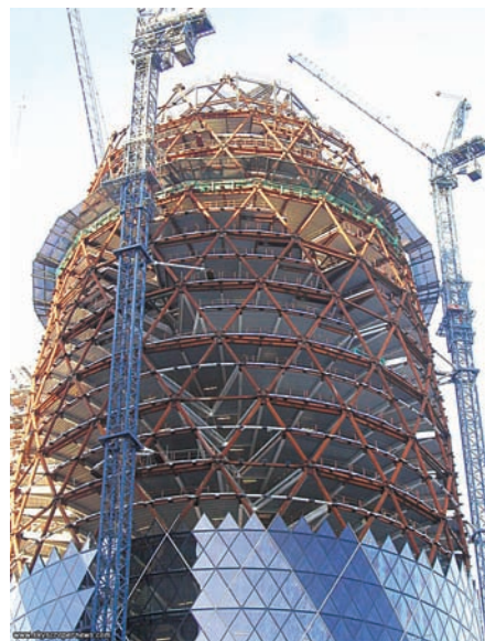
Λίγο πριν την ολοκλήρωση της κατασκευής
