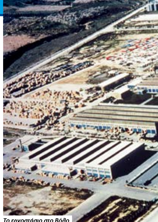
Το εργοστάσιο στο Βόλο
